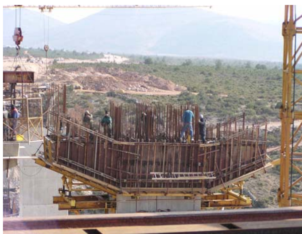
Slika 3. Skela i oplata naglavnice
