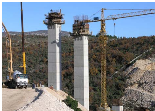
Slika 2 Skela i oplata stupova
